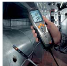
ダクトの内や排出口での 風速・風量計測
