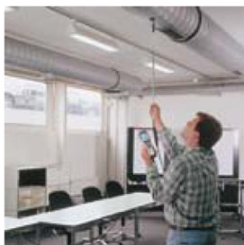
天井など、高所の 風速・風量計測
