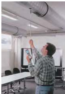
空調設備の風速・風量
