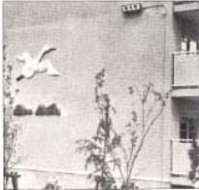
外装モザイクタイル接着(ボルト併用)
