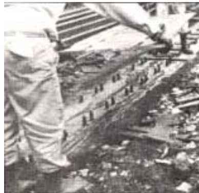
コンクリート製床板への鋼板接着補強
