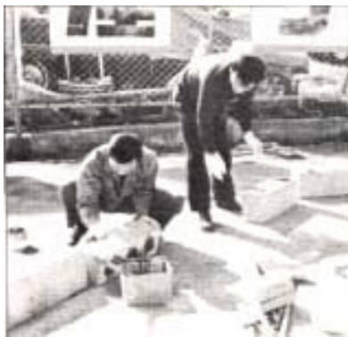
通行区分用コンクリートブロック接着
