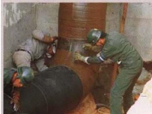
●冷却水用埋設鋼管の防食
