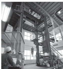
屋内試験鉄塔
